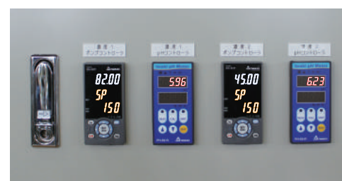
2つの炭酸次亜水のpHと送水量を測定
